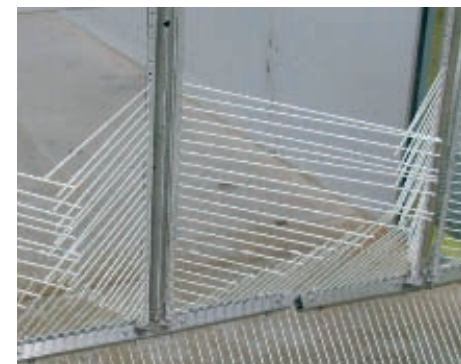
Fischabweiser mit flexiblen Kunststoffborsten und einzeln beweglichen Schwenkarmen.
